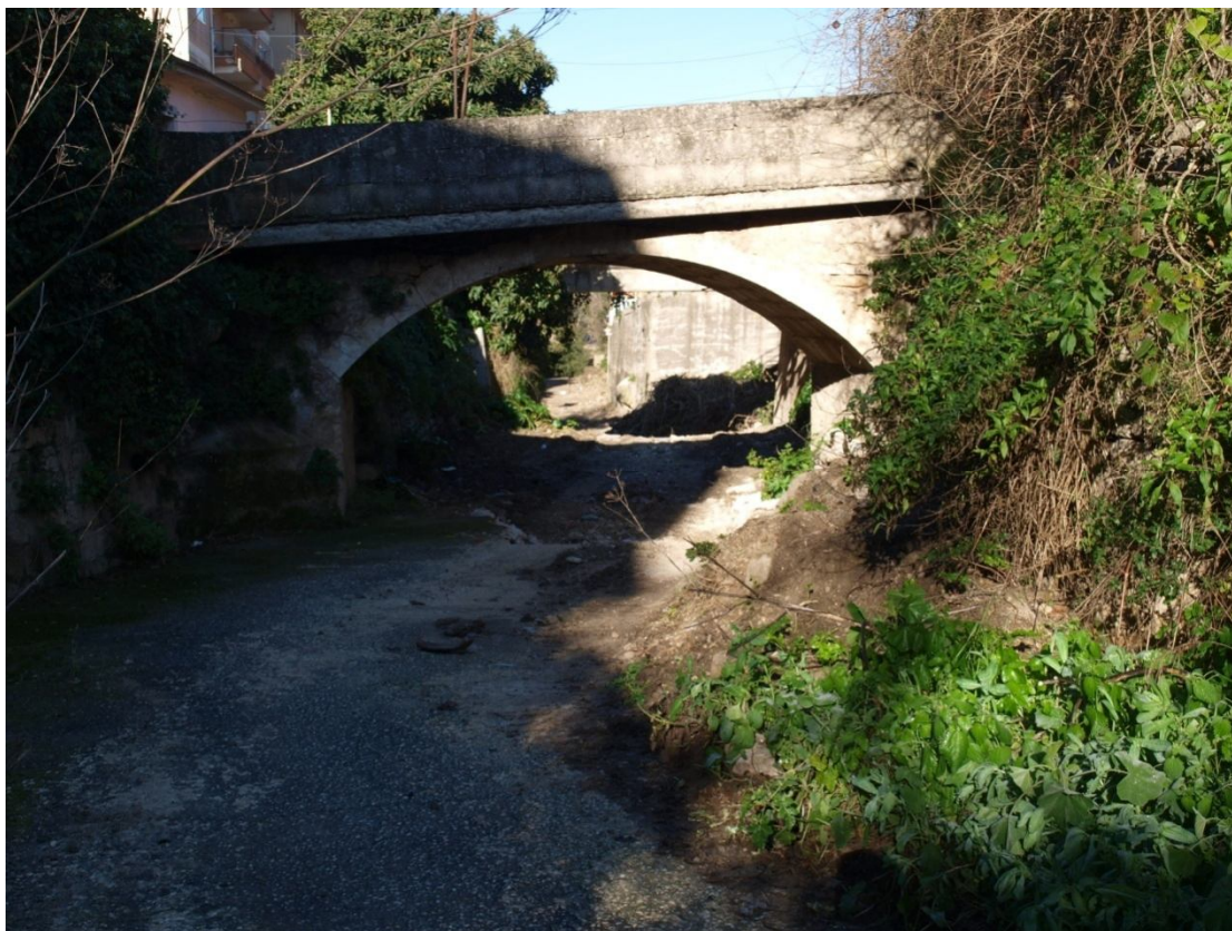
Fig. 9 Ponte sul San Liberale
