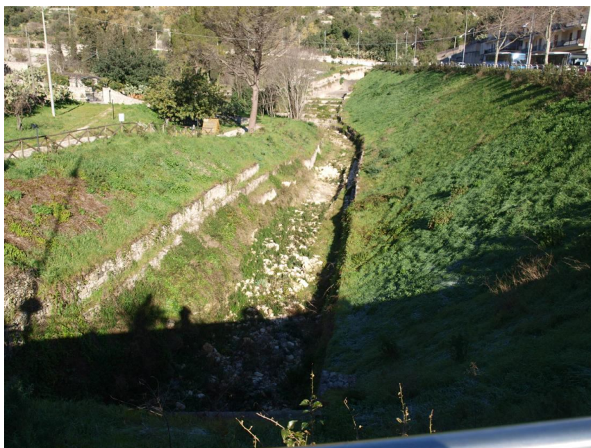
Figura 17: Foto realizzata da sopra l'inizio della tombatura dello Janni Mauro
