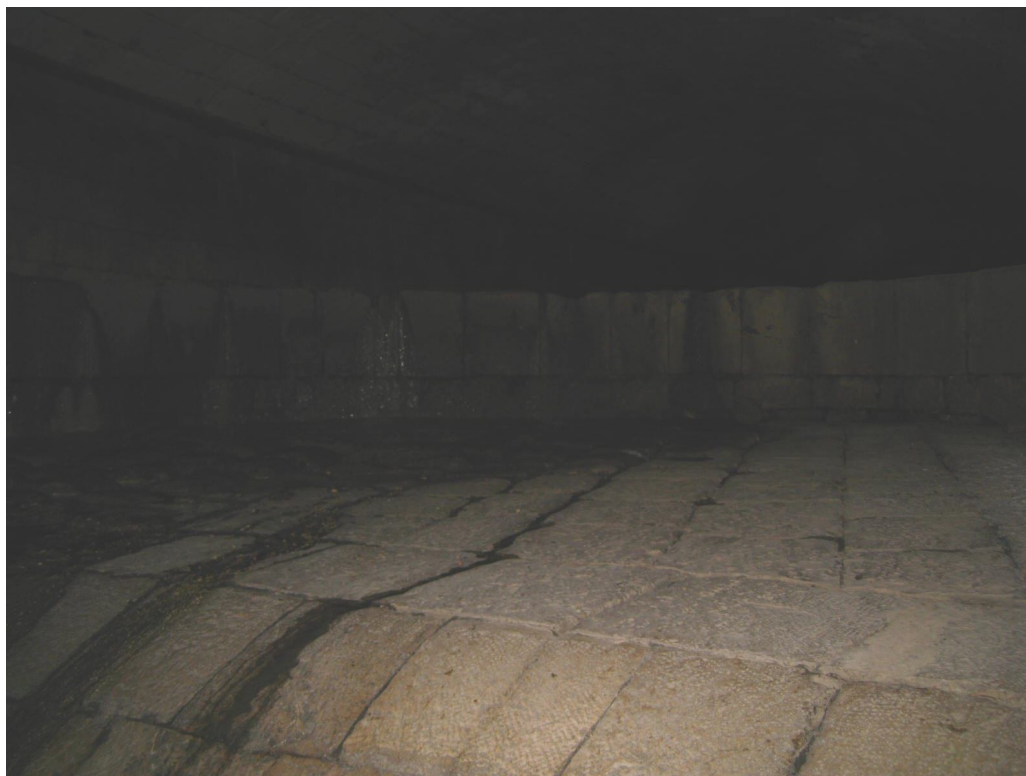
Fig. 13 manufatto in pietra sul San Liberale
